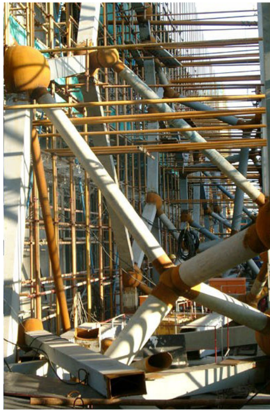
Abb. 10: Raumfachwerk im Bau
