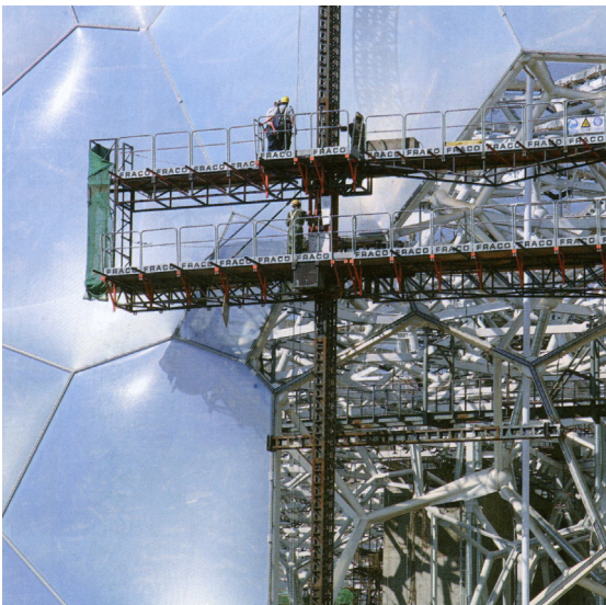
Abb. 12: Montage der Fassadenelemente
