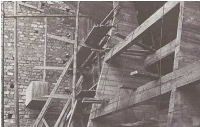
Stahlbetonskelett der Südfassade
