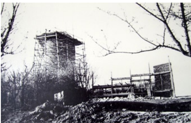
Bau der Türme aus Bruchsteinen
